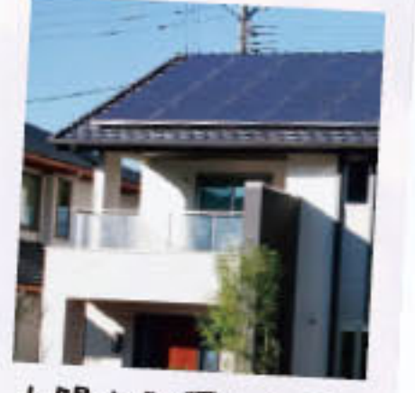
太陽光発電システム
